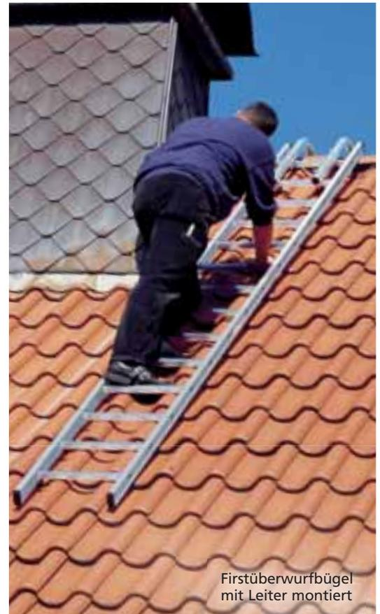
Firstüberwurfbügel mit Leiter montiert
